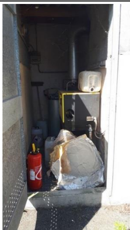
Photographie 9 : Cuve aérienne de stockage de fioul
